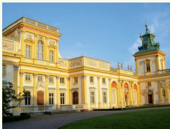
Il.6. Odrestaurowana elewacja pałacu
