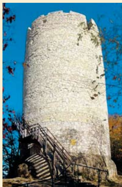
3. Kamienna wieża o okrągłym kształcie zwana basztą
