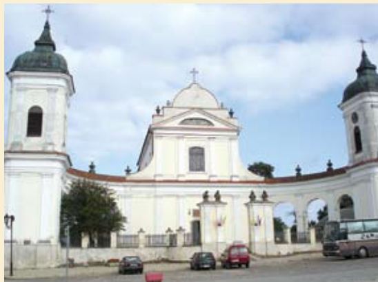
1. Zespół kościelno-klasztorny w Tykocinie. Kościół św. Trójcy zbudowany w latach 1742-1749 w stylu paladajskiego baroku
